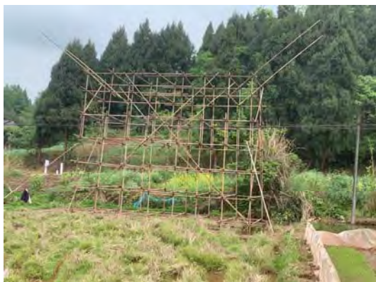
图7-5 跨越处脚手架
