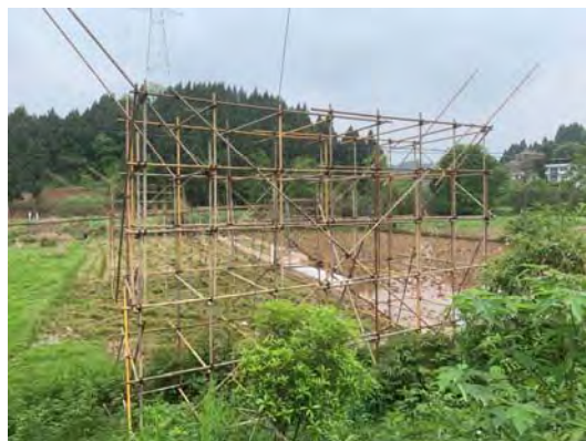
图7-6 跨越处脚手架
