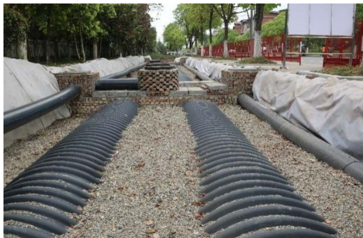
图 5-21 钢带波纹管蓄水带试点案例（芳洲路）
