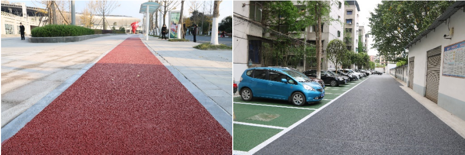
图 5-7 透水混凝土试点案例（左：体育公园骑行道，右：市政府小区院坝/停车场）
